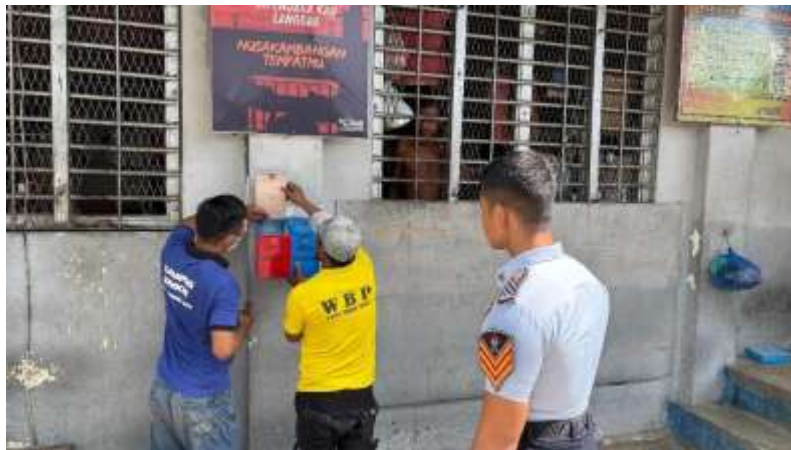
Gambar 5. Proses pemasangan Kotak Saran Dua Fungsi
