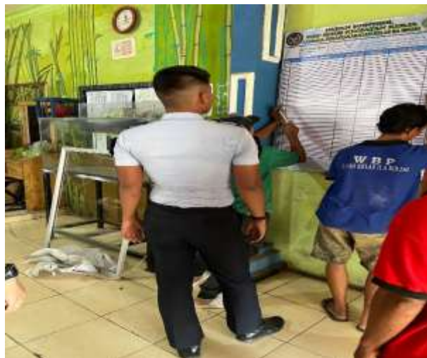
Gambar 2. Proses Pemasangan papan kontrol serta kaca di bimker
