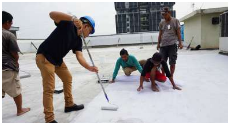
Gambar 5: Aplikasi Heatgrad dengan menggunakan roll (Sumber: Foto sendiri mencoba aplikasi Heatgrad dengan roll pada permukaan beton)
