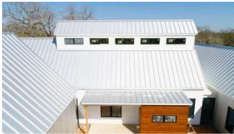
Gambar 4: Atap metal galvalume berwarna terang untuk mengurangi penyerapan panas. (Sumber: https://dekoruma.com )
