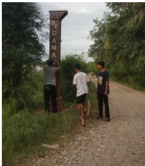
Gambar 2. Pembuatan Gapura di Desa Danau Lamo
