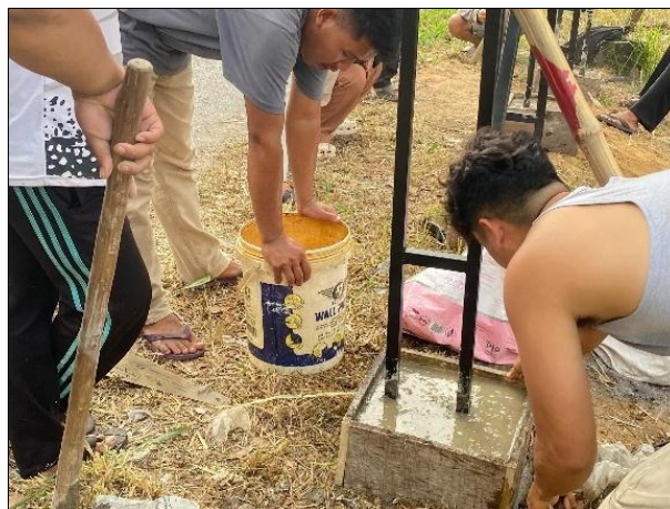
Gambar 6. Pemasangan Pondasi Ecobrick Pada Rangka Besi Bersama Masyarakat
