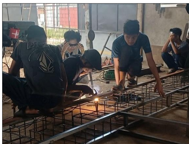
Gambar 2. Pembuatan Rangka Besi bersama Tukang Las
