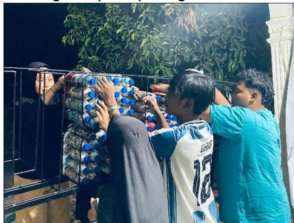
Gambar 4. Pemasangan Ecobrick Pada Rangka Besi
